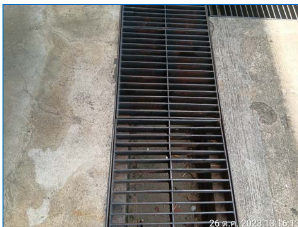
รูปที่ 2.20 ตะแกรงดักขยะ
